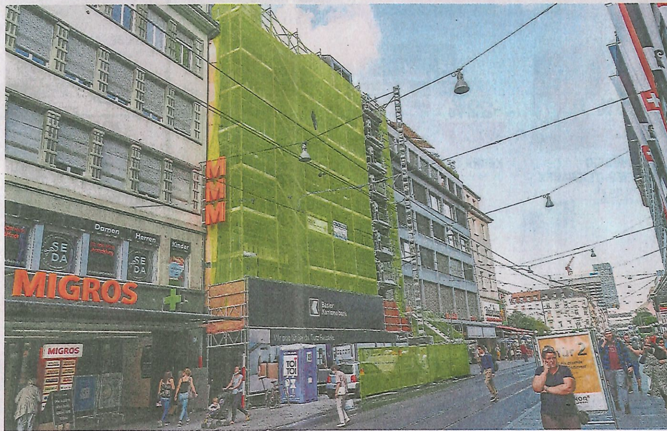
Nicht zu übersehen: Das Bild der Grossbaustellé dominiert die Greifengasse.
