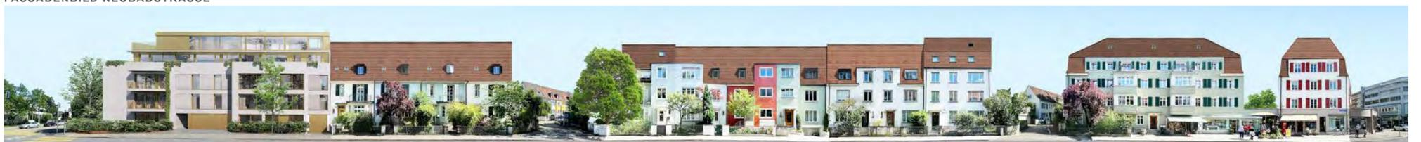
Grundsätzlich wird bei dieser Variante die Idee der massiven Gebäudehülle (Beton) auf der Strassenseite und einer leichten Fassade auf der Hofseite dargestellt. Die Betonfassade wird im Erdgeschoss fortgesetzt und die Öffnungen werden in dieser als Lochfassade ebenso bei den Garagen ausgebildet. Die Einteilung der oberen Geschoße übernimmt die Geometrie des Erdgeschosses. Die Verzierungen in der Fassade werden als Betonrelief (Matrizen) ausgebildet.
